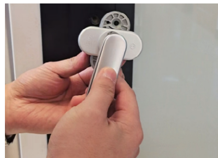
2. Gire la cubierta para mostrar los orificios de los tornillos
