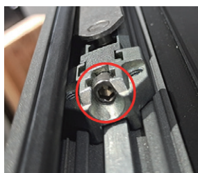
Tornillo en la parte superior del sash
