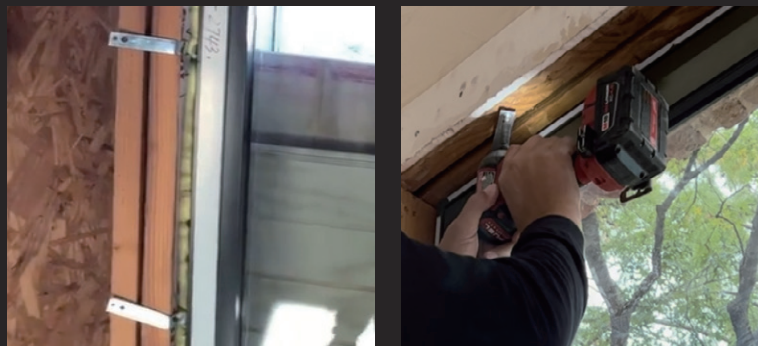
Fije los clips/correas metálicas a la pared
